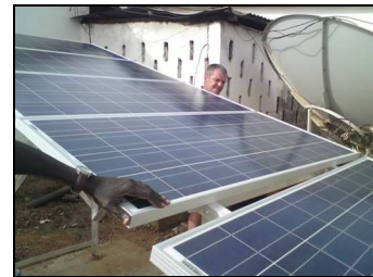
Matthias, Amadou, Vasyl und Rolf befüllen die Batterien mit Schwefelsäure und befestigen die Solar Panels auf den Gestellen. Fotos: ©2011 Projekthilfe Dritte Welt e.V.
