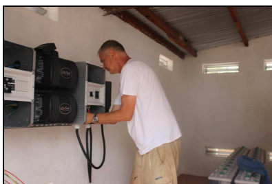
Rolf Kuhleemann montiert Laderegler und Inverter.
