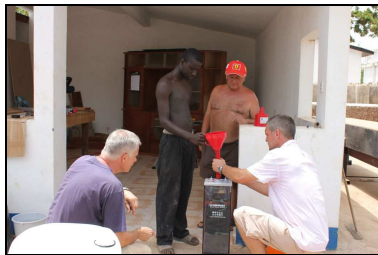
Matthias, Amadou, Vasyl und Rolf befüllen die Batterien mit Schwefelsäure und befestigen die Solar Panels auf den Gestellen. Fotos: ©2011 Projekthilfe Dritte Welt e.V.
