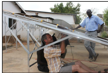
Matthias, Amadou, Vasyl und Rolf befüllen die Batterien mit Schwefelsäure und befestigen die Solar Panels auf den Gestellen. Fotos: ©2011 Projekthilfe Dritte Welt e.V.
